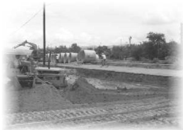
Instalación de la tubería del Colector Domingo Rubí de 183 cm de diámetro.
