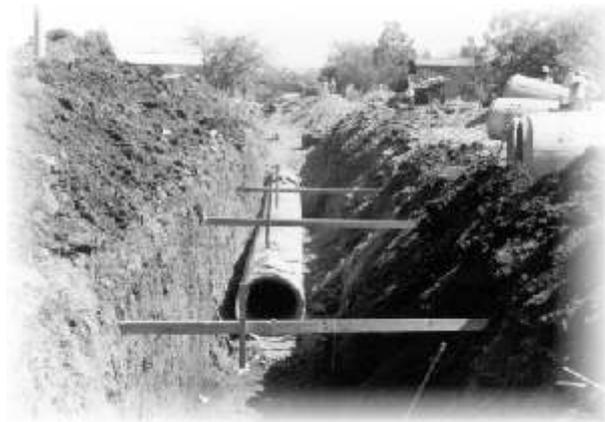
Instalación de tubería de concreto de 76 cm de diámetro para Alcantarillado Sanitario.
